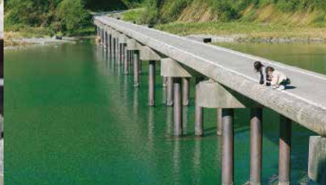
名越屋沈下橋
